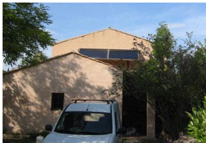
En garde-corps au-dessus d'un pan de toit
